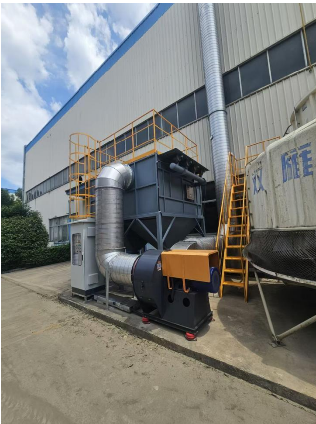
落砂废气处理设施
